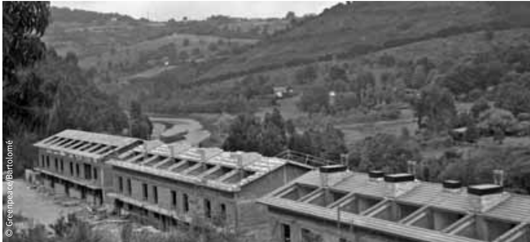
Urbanización en construcción junto a la ría de Plentzia, Bizkaia.
