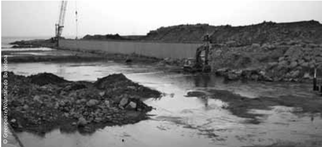
Obras en el colector de la depuradora de Barcelona.
