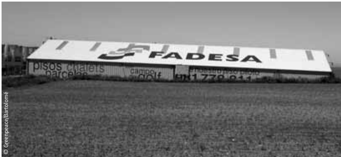
Nave con publicidad de FADESA en Perbes, A Coruña.
