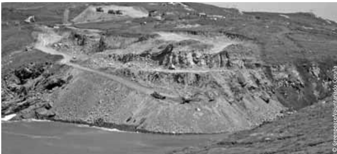
Obras de construcción del puerto exterior de A Coruña.
