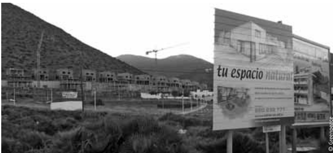
Construcción de viviendas en San José, Almería, en el Parque Natural Cabo de Gata Níjar.
