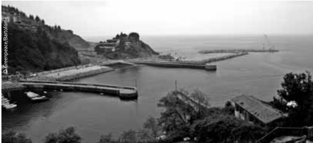
Obras de ampliación del puerto de Mutriku, Gipuzkoa.
