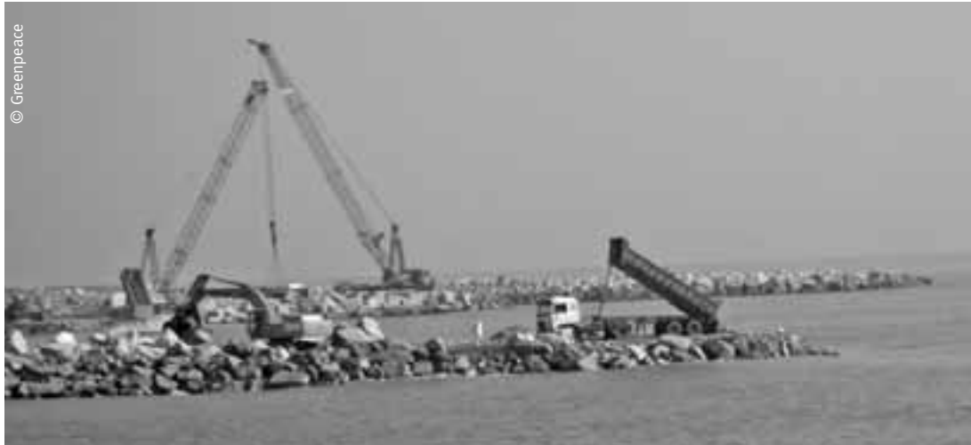
Obras del futuro zoo en la costa de Barcelona.
