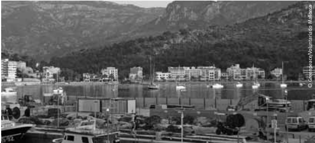
Obras de ampliación del Port de Sóller (Mallorca).
