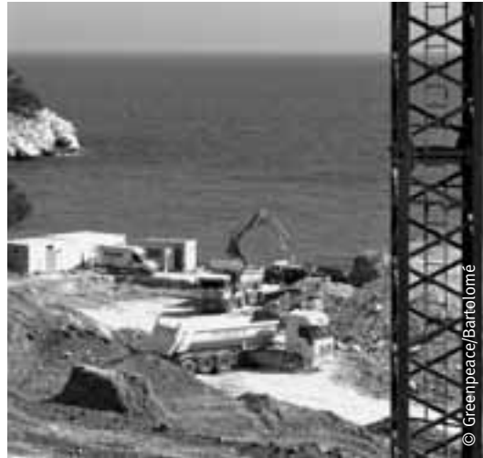
Maquinaria pesada preparando el terreno para la construcción de edificios en Altea, Alicante.
