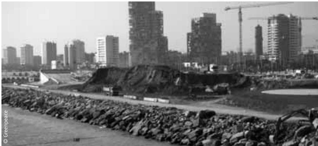
Obras de construcción del zoo de Barcelona, ganando terreno al mar.
