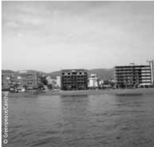
Edificaciones en primera línea de playa en el litoral malagueño.
