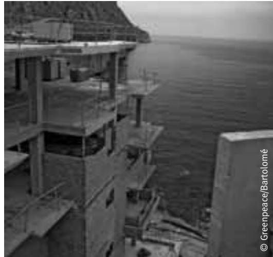
Construcción al borde del mar en Altea, Alicante.
