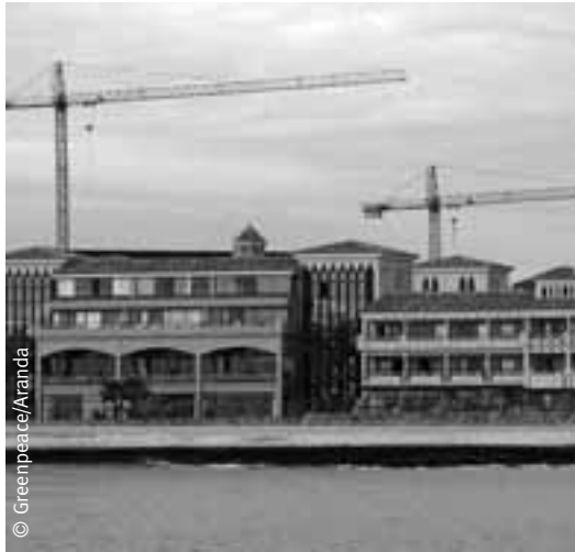
Construcciones en primera línea en Corralejo, Fuerteventura.
