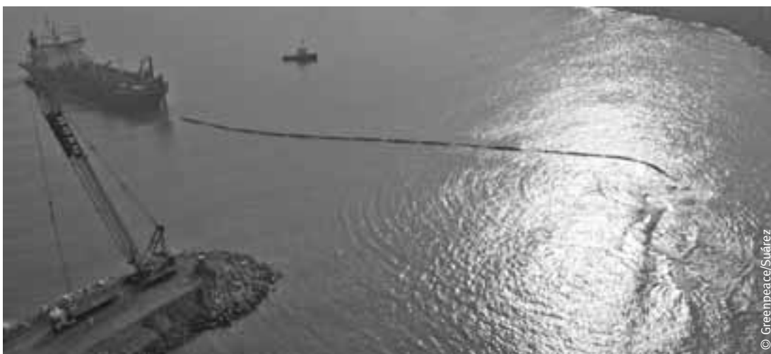
Dragado y construcción del súper puerto de El Musel, en Gijón.
