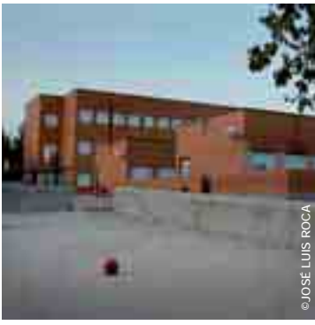
Imagen general del Colegio Valdebernardo (Madrid).
