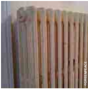
Detalle de radiador doméstico utilizado dentro del sistema de calefacción de carbón en un domicilio de Madrid.
